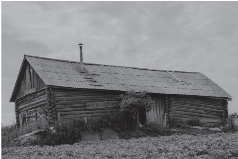
Рис. 1. Общий вид. Дом по адресу ул. Таежная «14»
